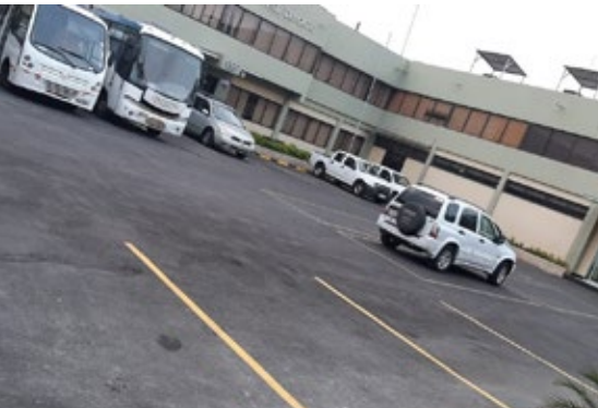
■ Drenaje alcantarillado y asfalto del parqueo del COE.
